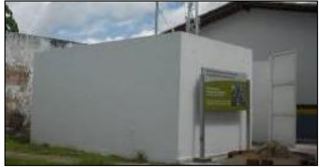
FOTO 04: Estação de monitoramento do ar localizada no bairro do Bacanga.
