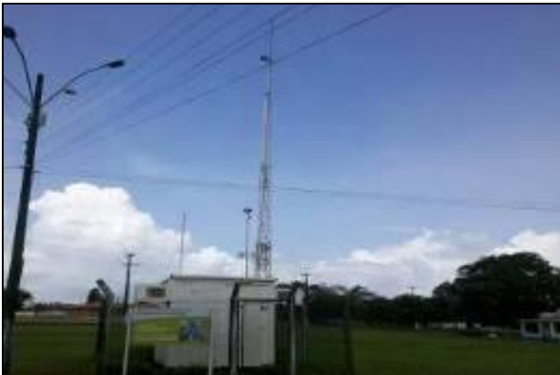
FOTO 03: Estação de monitoramento da qualidade do ar localizada na UEMA.
